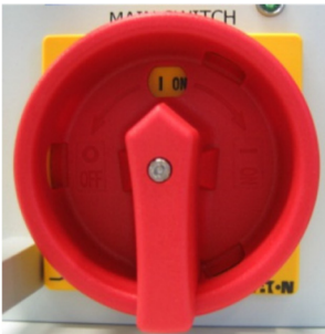
Γενικός διακόπτης (MAIN SWITCH)
